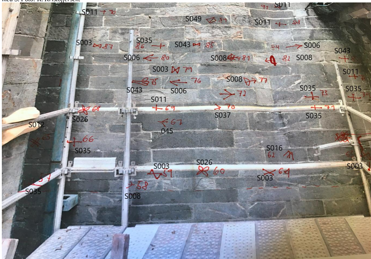
Figur 15 Østveggen i småtta, nordre tverrskip på triforienivå. Godt bevart murverk med mange steinhuggermerker. Typenummer begynner med S. Foto: K. Kristoffersen.
