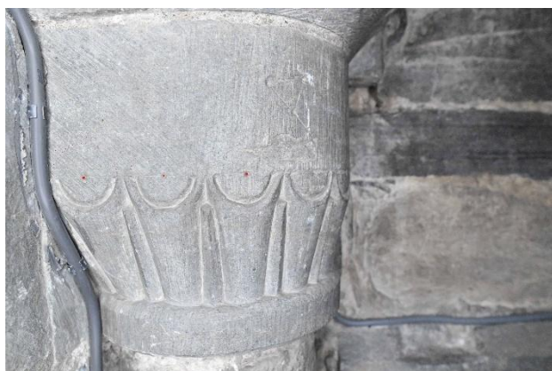
Figur 22 Kapitel med både steinhuggermerket til S003 og spor etter passer. Sistnevnte er markert med rødt. Foto: K. Kristoffersen.
