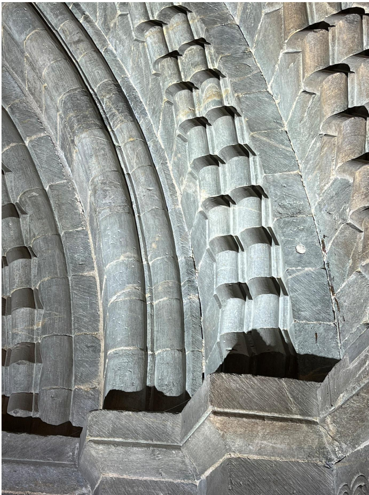
Figur 20 Steinhuggermerker på buestein med chevrongedkor på kapellbuen i Lektoriet. Selv om merkene er risset inn svakt, så er det mulig å se en del av dem. Foto: K. Kristoffersen.
