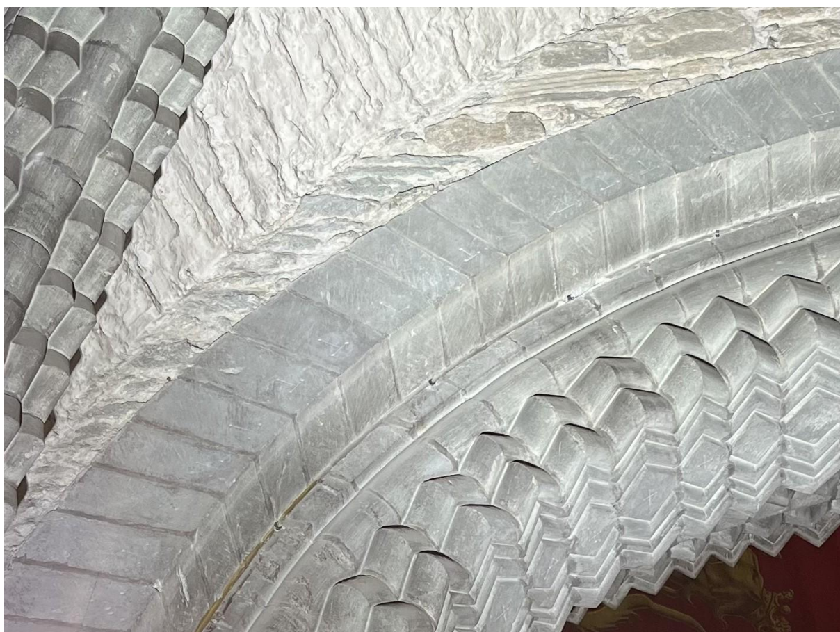
Figur 21 Baksiden av buen med S001 et merket utformet som en T. Foto: K. Kristoffersen.
