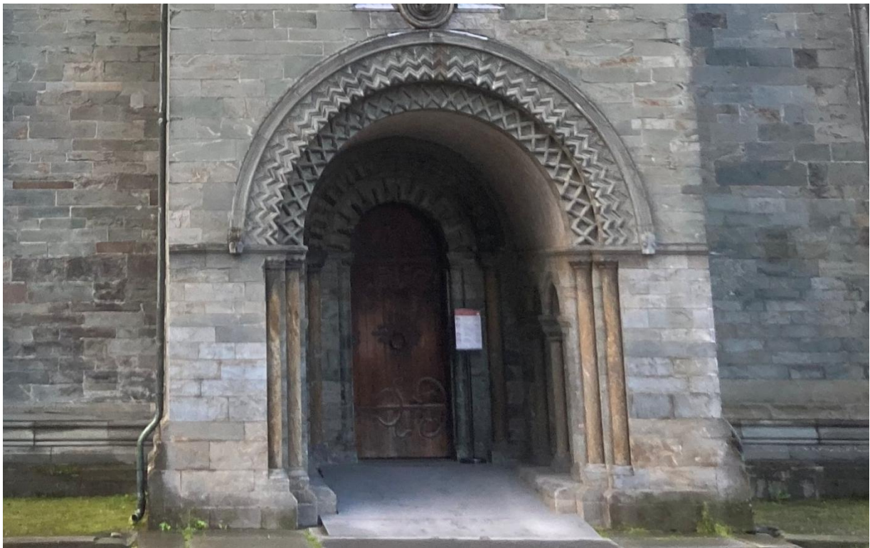
Figur 8 Forhallen utvendig på nordre tverrskip. Murverket er hardt restaurert. Foto: K. Kristoffersen.
