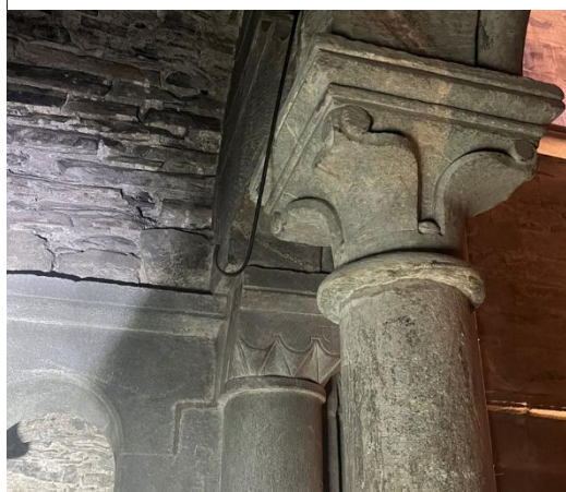
Figur 24. Overgangen mellom østre og nordre triforium. Waterleaf kapitel i foran og foldekapitel lengst bak.. Foto: K. Kristoffersen.
