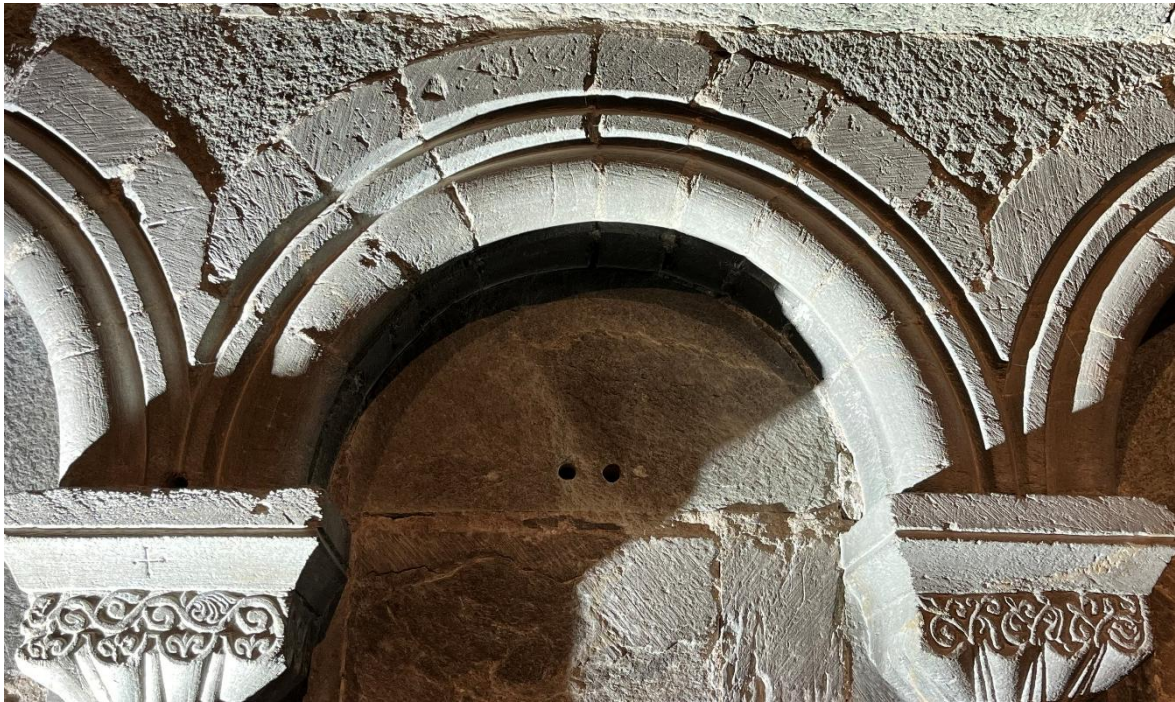
Figur 18 Steinhuggermerker på en del av blindbuen i Lektoriet. Foto: K. Kristoffersen.
