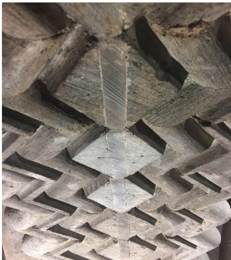
Figur 9 Innfelling av stein på første bueledd. Foto: K. Kristoffersen.
